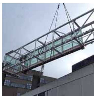
Demontage is het nieuwe slopen!
